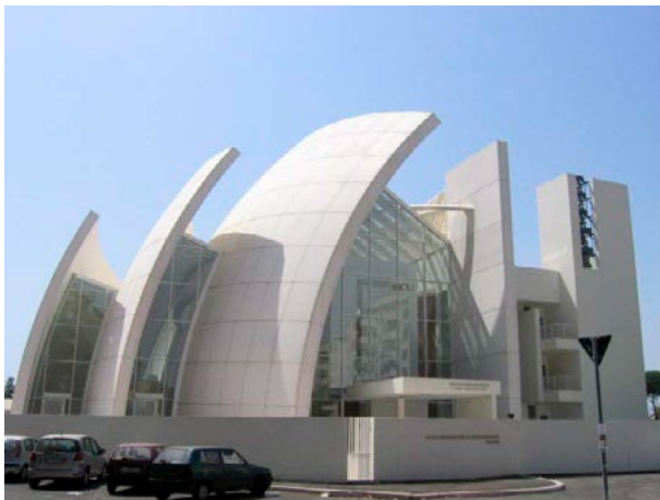
Figura 3. Edificaciones e infraestructura con concretos y morteros con capacidad de auto-limpieza y purificación del aire (Maury Ramírez A., 2011).
